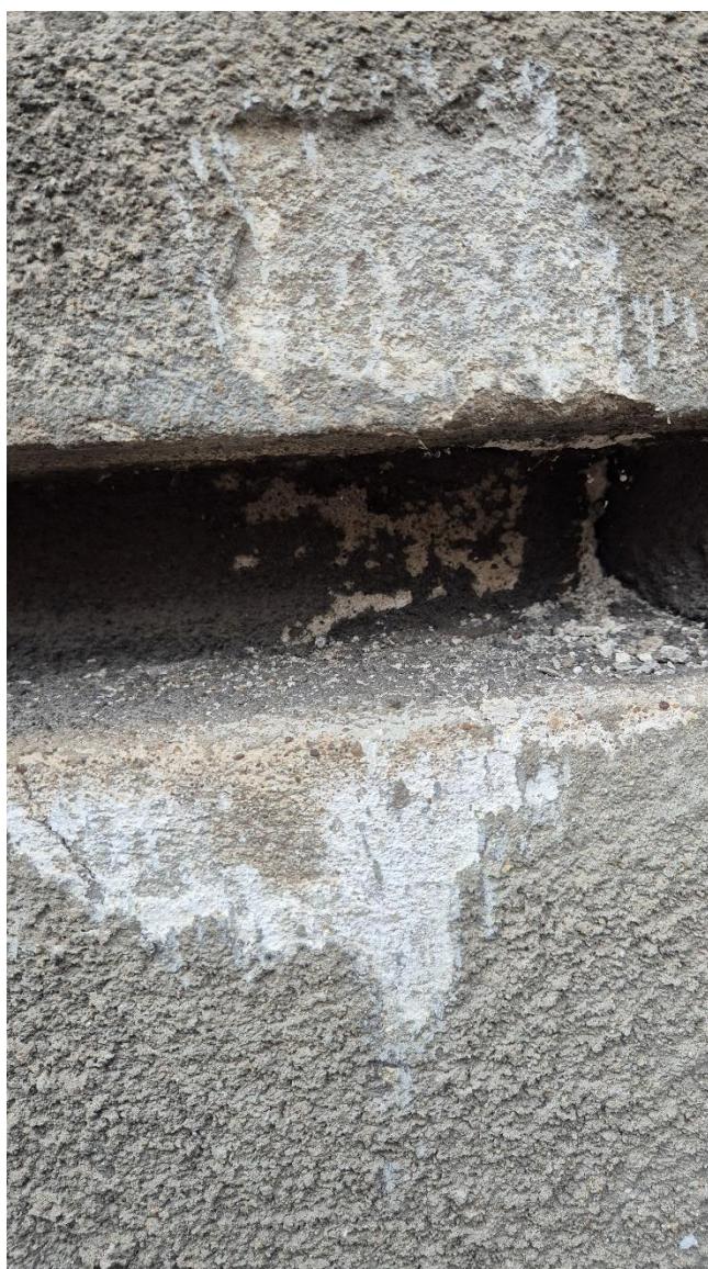
FOT. 7-8. Odkrywka sondażowa na dwuwarstwowym parapecie pod oknami pierwszego piętra. Pod wtórnym, nakrapianym tynkiem zachowany jest oryginalny tynk wapienny z naturalną patyną na powierzchni, na którym widoczna jest warstwa malarska w kolorze białym (pobiata wapienna).
