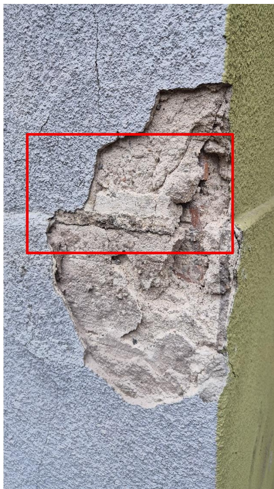
FOT.27-29. Odkrywka sondażowa na narożniku cokotu elewacji frontowej, na ścianie ganku, po prawej stronie wejścia do budynku. Na spękanym tynku wapiennym widoczne są pozostałości powłoki malarskiej w kolorze białym (warstwa podkładowa dla [pierwotnej warstwy malarskiej?])
