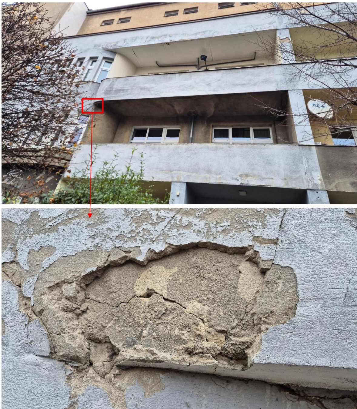
FOT. 5-6. Odkrywka sondażowa na styku łuku lewej strony elewacji (ściana z pionowymi oknami), ściany balkonu na pierwszym piętrze nad wejściem do budynku oraz balustrady balkonu na drugim piętrze. Pod wtórną warstwą tynku zachowany jest oryginalny tynk wapienny, pokryty patyną naturalną, niemalowany, bez śladów jakiegokolwiek warstwy malarskiej. Tynk ten jest spękany, ma osłabioną strukturę.
