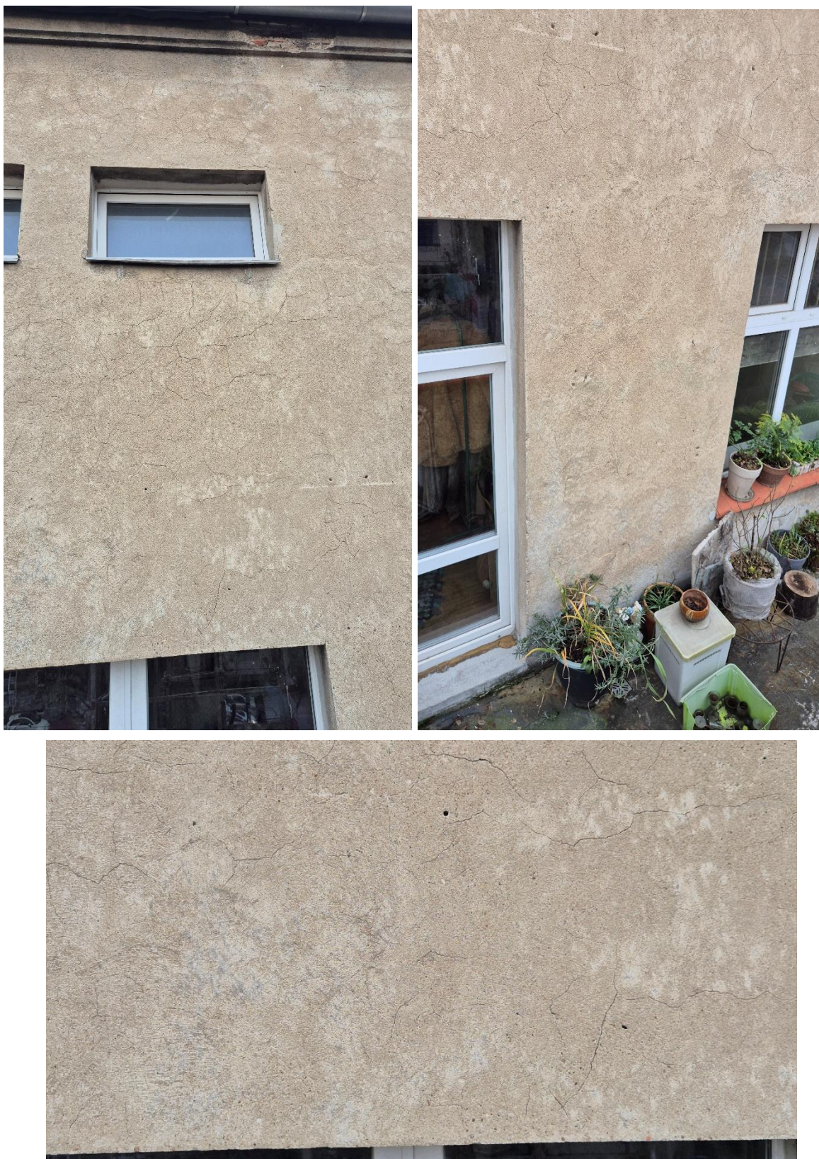
FOT.15-17. Fragmenty elewacji budynku na najwyższej kondygnacji, gdzie oryginalny tynk wapienny jest ekspozowany w pierwotnej formie, bez warstw wtórnych. Na jego powierzchni widoczna jest naturalna patyna, wymyta lokalnie przez zaciekającą wodę opadową (np. plama tuż uszkodzeniem gzymsu wieńczącego). Powierzchnia tynku jest wypłukana i pokryta siatką spękań.
