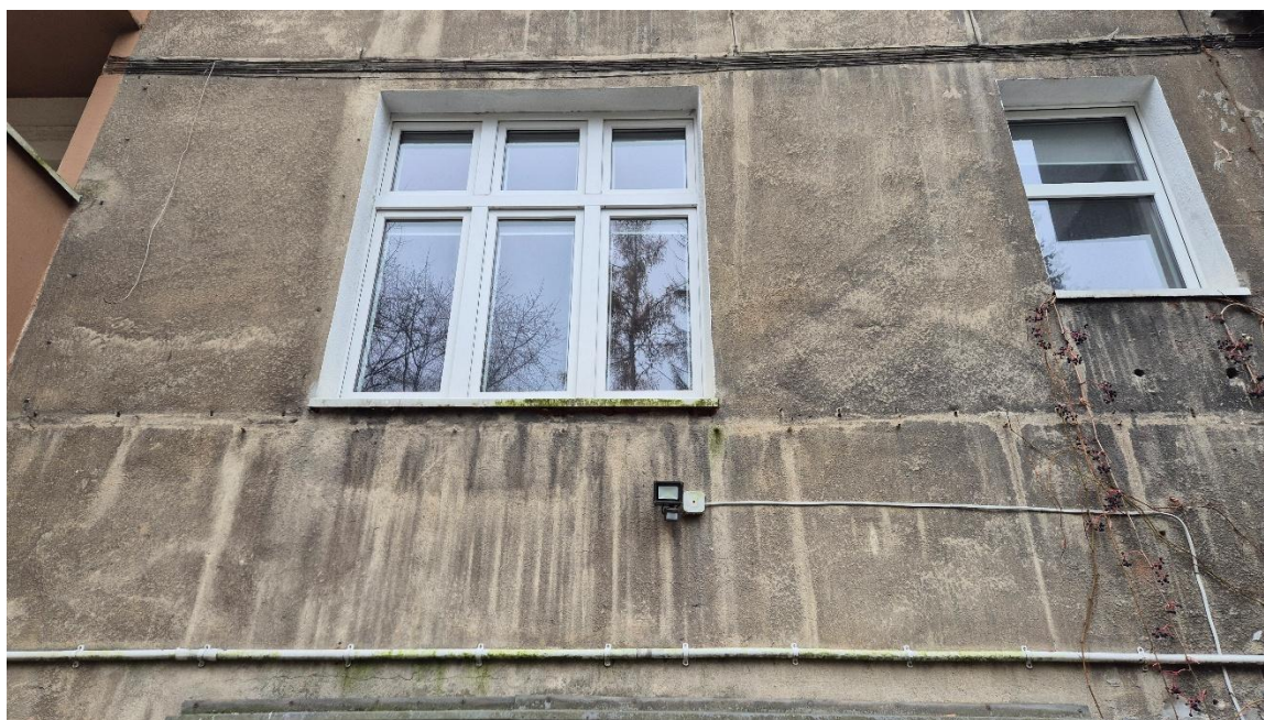
FOT.30-31. Tylna elewacja kamienicy, obecny stan zachowania. Na większości powierzchni elewacji eksponowany jest oryginalny tynk wapienny pokryty patyną naturalną i zabrudzeniami. Jaśniejsze plamy w formie zacieków to efekt obmywania elewacji przez wodę opadową. Wtórne warstwy malarskie widoczne są tylko na balustradach i części ścian balkonów.
