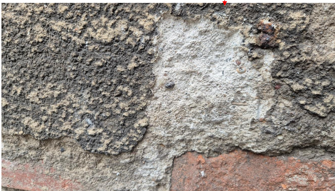
FOT. 34-35. Odkrywka sondażowa na tylnej elewacji budynku, na poziomie parteru. Widoczne są w tym miejscu warstwy chronologiczne - mur ceglany i jedyna obecna na nim warstwa tynku wapiennego o składzie identycznym z tynkiem zachowanym na elewacji frontowej. Na powierzchni tynku brak jest śladów powłok malarskich. Widoczna jest tylko patyna naturalna i zabrudzenia.
