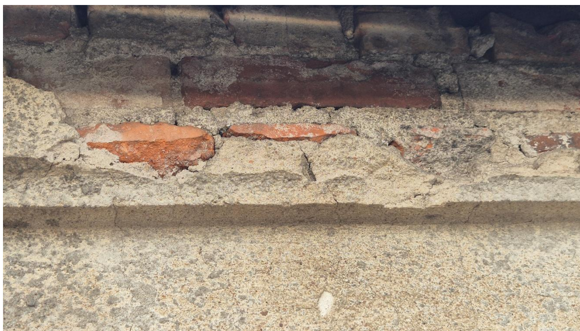
FOT.18-19. Fragment gzymsu pod rynną. W miejscu uszkodzenia widoczny przekrój przez warstwy chronologiczne – na podłożu, którym jest mur ceglany widoczna tylko jedna warstwa tynku wapiennego. Skład zaprawy murarskiej widocznej między cegłami jest analogiczny do składu zaprawy tynkarskiej.
