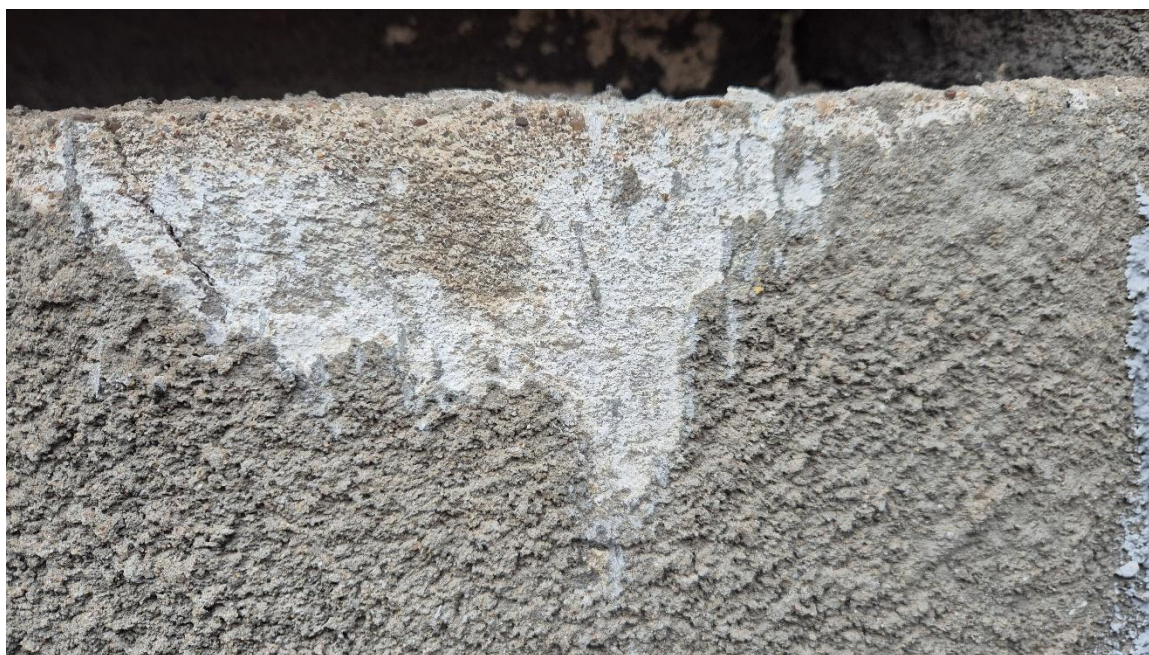
FOT. 11-12. Odkrywka sondażowa na dwuwarstwowym parapecie pod oknami pierwszego piętra. Pod wtórnym, nakrapianym tynkiem zachowany jest oryginalny tynk wapienny z naturalną patyną, na którym widoczna jest warstwa malarska w kolorze białym (pobiała wapienna).
