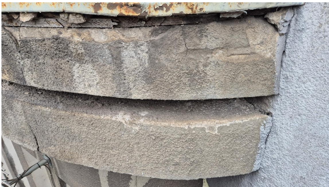
FOT. 7-8. Odkrywka sondażowa na dwuwarstwowym parapecie pod oknami pierwszego piętra. Pod wtórnym, nakrapianym tynkiem zachowany jest oryginalny tynk wapienny z naturalną patyną na powierzchni, na którym widoczna jest warstwa malarska w kolorze białym (pobiata wapienna).
